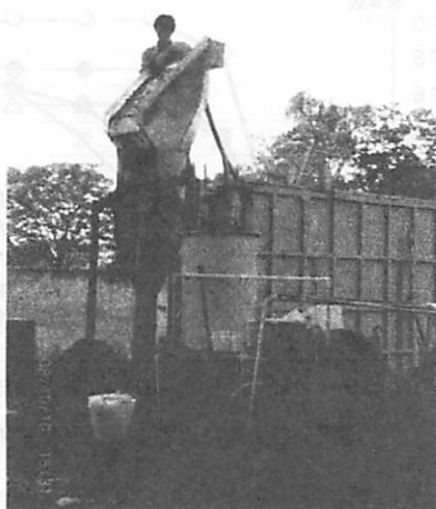
写真2 スクリーン凝集ろ過装置全景 (右側の大きな矩形水槽は使用しない)
