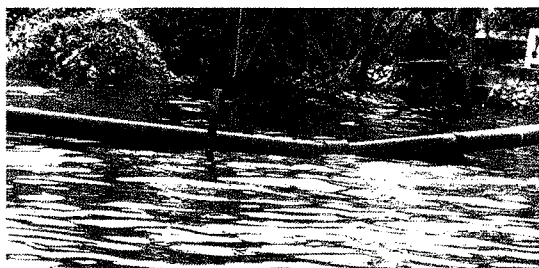
写真4 折れ曲がった水道管
