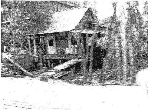
写真1 堤防に隣接する民家
