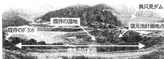
写真-1 掘削岩埋立造成地着工前の状況
