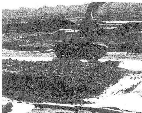
写真-2(b) 止水シートによる湿地の造成状況
