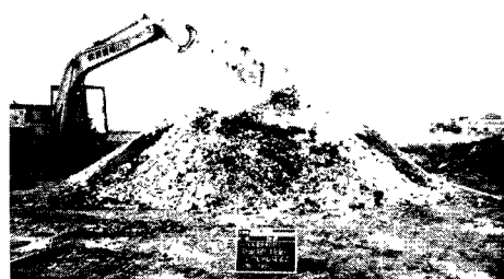
写真－1 混合状況
