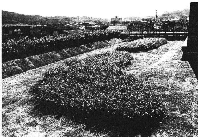
写真－3 ミラクルソルを用いた屋上緑化の施工事例
