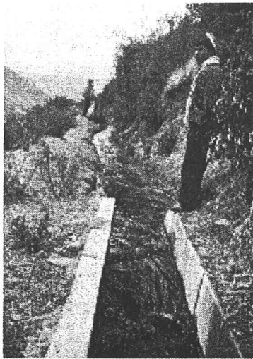
写真—1 4 キンサコチャ湖からの 更新水路の末端部
