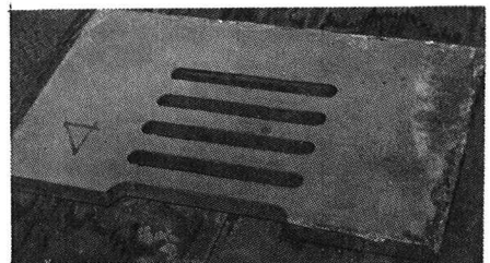
写真-2(a). 側溝ます蓋(A型) (1個の穴面積3×30cm 2 , 穴間隔4cm)
