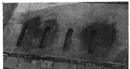
写真-2(b). 側溝ます蓋(B型) (1個の穴面積17×3cm 2 , 穴間隔11cm 縁石側と穴の間隔5cm)
