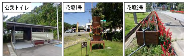
写真-1 花壇 1 号、2 号及び公衆トイレの様子
