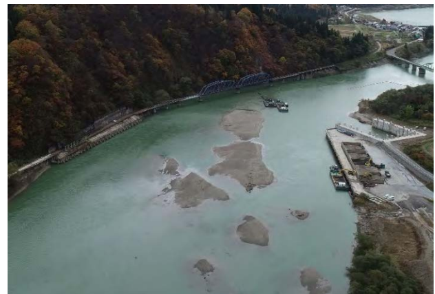
写真-2 台風による土砂流入
