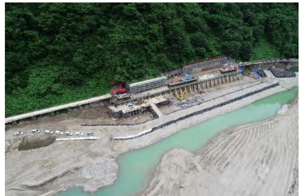
写真-4 仮締切完了 擁壁補強工事施工状況
