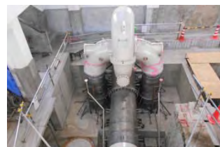
写真-3 ケーシング据付状況
