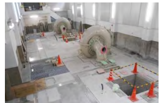
写真-4 基礎改良工事完成状況
