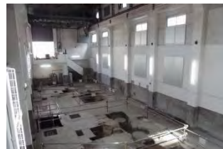
写真-1 着工前状況
