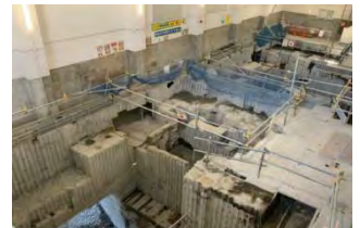
写真-2 基礎撤去工事完成状況
