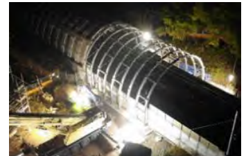
写真-3 主構架設完了
