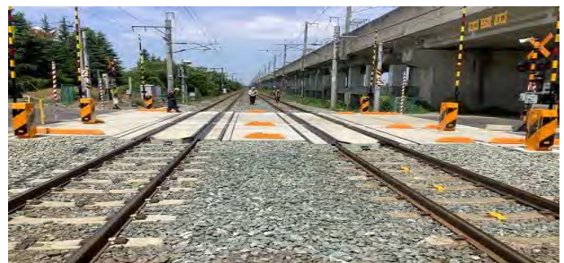
写真-6 白沢踏切 施工後
