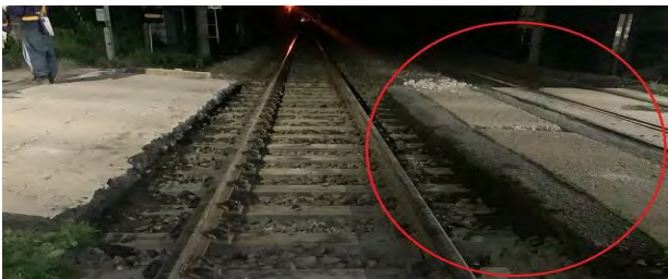
写真-3 白沢踏切線間撤去前
