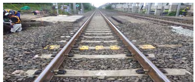
写真-2 白沢踏切道床交換箇所
