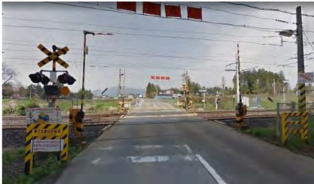
写真-1 施工箇所 白沢踏切
