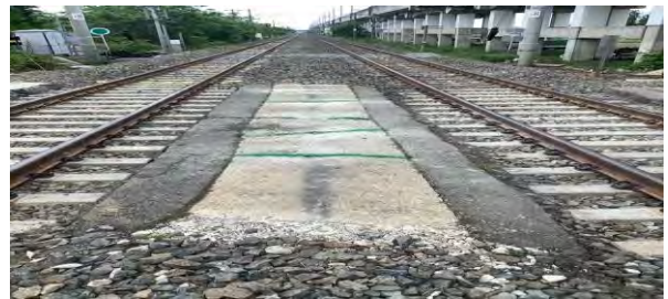
写真-5 線間小割り作業 施工後
