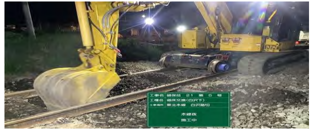
写真-4 道床交換(施工中)
