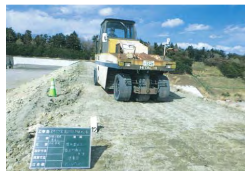
写真-2 施工状況
