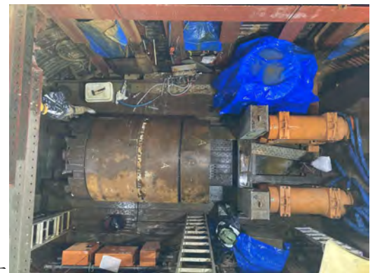
写真-1 推進機設置状況
