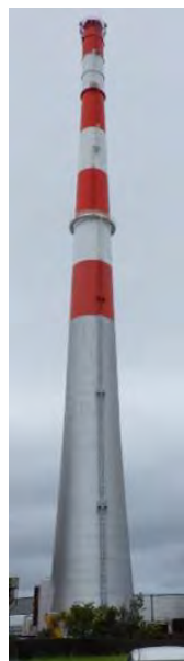
写真-1 煙突全景
