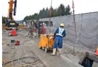
写真-2 床版吊り切り撤去状況
