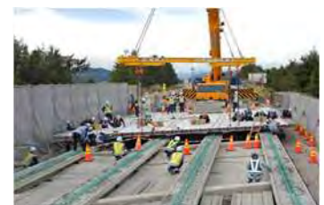
写真-5 コッター床版架設
