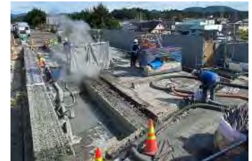
写真-3 WJ 工法状況
