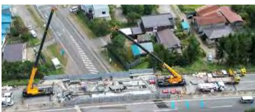
写真-1 既設床版撤去状況
