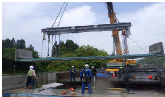
写真-5 架設状況
