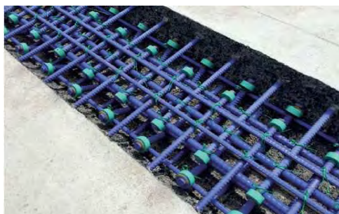
写真-4 MuSSL 工法施工写真
