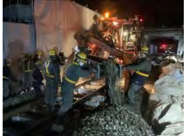
写真-2 掘削状況
