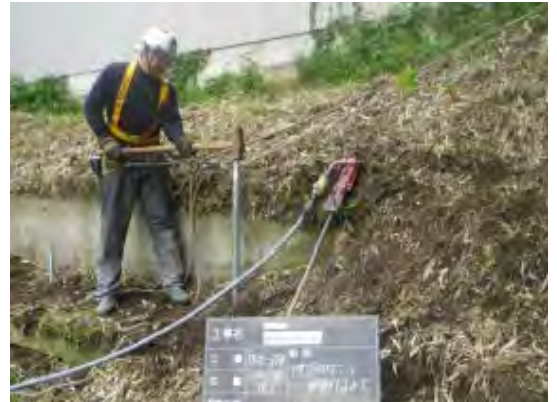
写真-3 既設排水溝縦壁補強アンカー打込み
