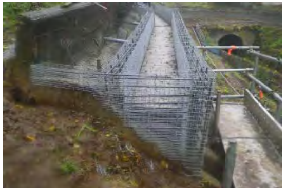
写真-4 排水溝部組立状況
