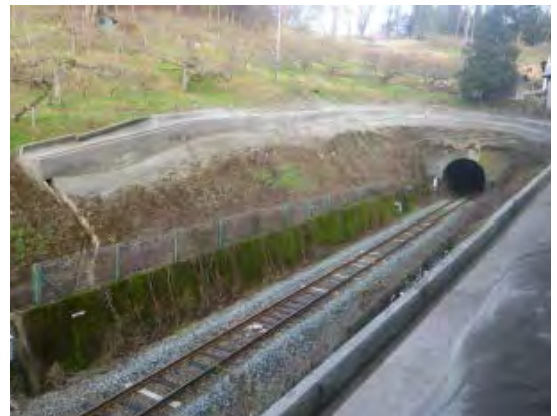
写真-5 吹付排水溝全景
