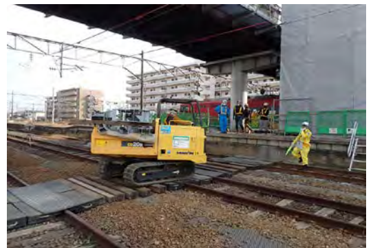
写真-1 重機による線路横断の運搬
