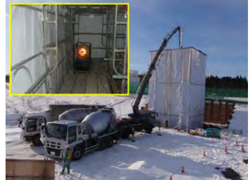
写真-1 寒中施工の様子
