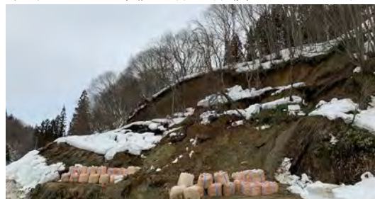
写真-1 崩壊地全景(3月16日撮影)
