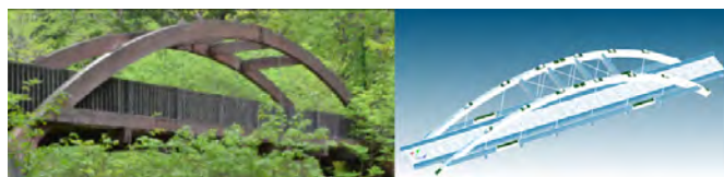
図-1 旧めおと橋の外観と解析モデル
