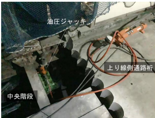
図-3 ジャッキアップによる重量確認
