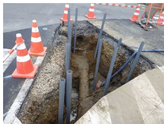
写真-2 ガイド管の据付状況
