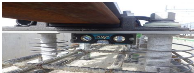
写真-2 タイプレート底面の水平確認
