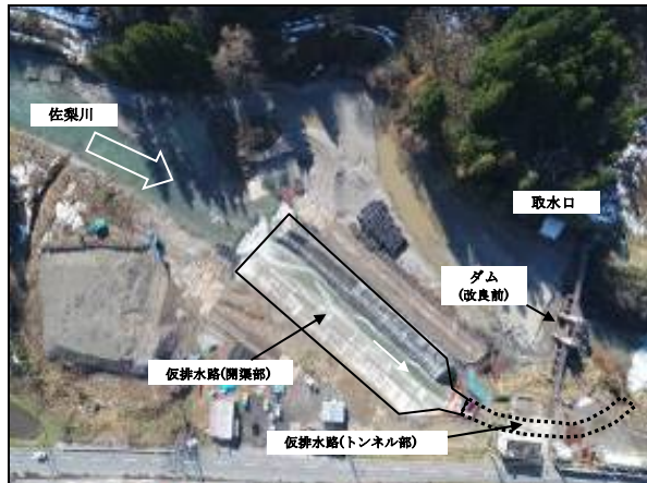
写真－2 仮排水路全景写真(2017年12月1日時点)
