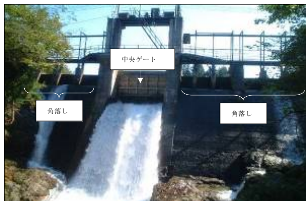
写真－1 ダム背面状況（改良前）
