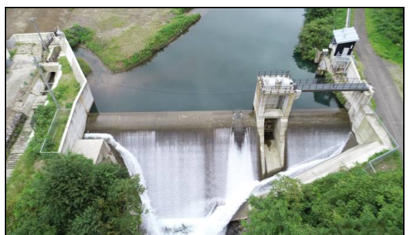
写真－3 ダム背面状況(改良後)
