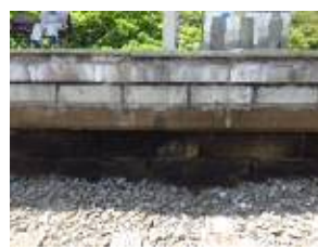
図-6 ④盛土ホーム (石積擁壁)
