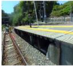
図-4 ①桁式ホーム
