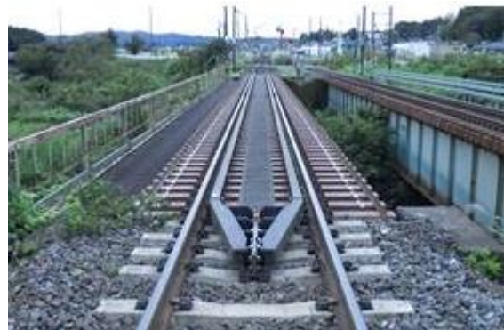
写真-2 瀬峰川 B 施工後
