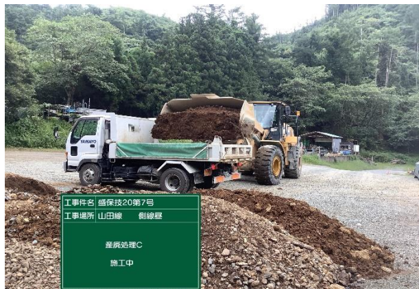
写真-3 発生土の運搬作業
