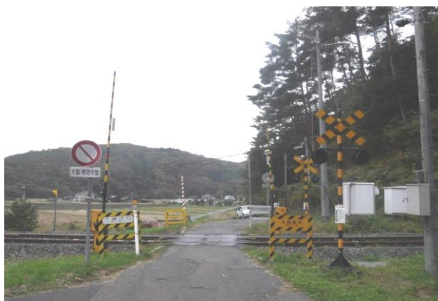
写真-1 大誘踏切施工前風景
