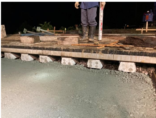
写真-2 砕石補充、砂利止め設置前
