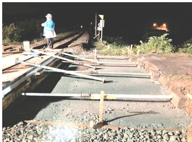
写真-4 ハイプサポートを使用した砂利止め
