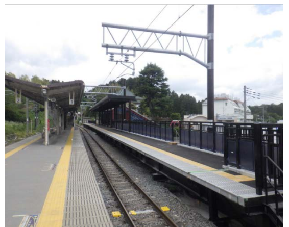
写真-1 工事桁撤去・軌道復旧完了
