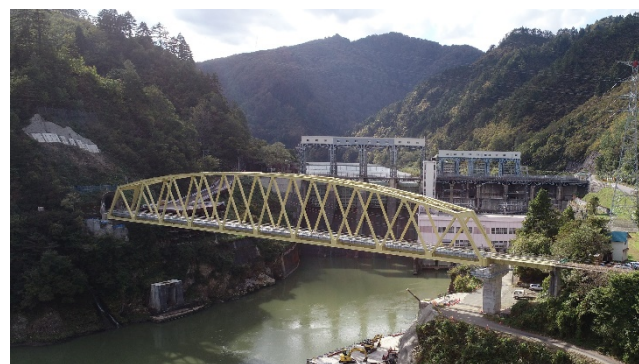
写真-2 橋りょう架設完了
