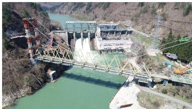
写真-1 橋りょう架設状況
