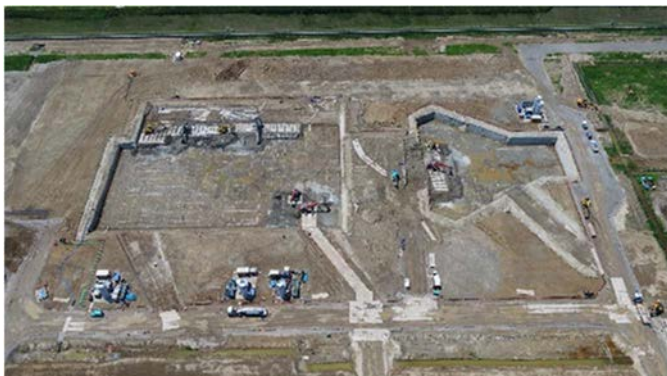
写真－1 斜め土留め施工状況
