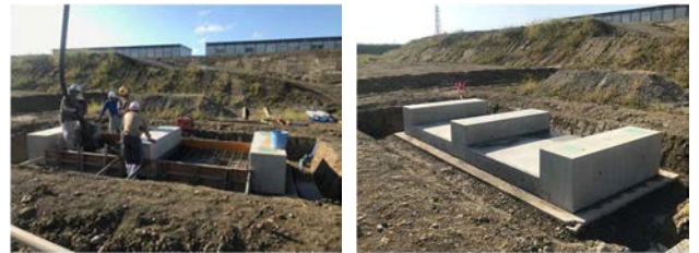
写真－2 配管スリーパー基礎施工状況
