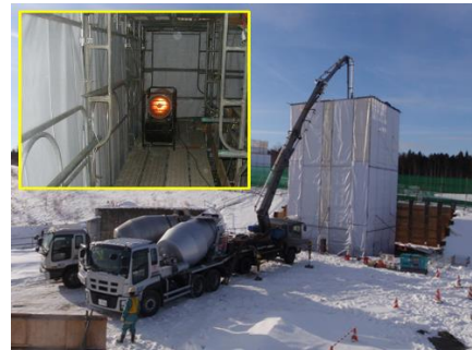
写真-1 寒中施工の様子
