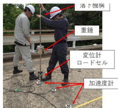
写真1 小型 FWD 試験実施状況
