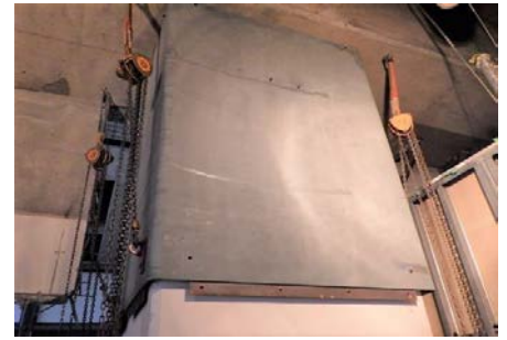
写真-2 上部鋼板吊り上げ状況
