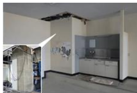
写真-1 施工前(B-1柱)
