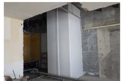
写真-3 施工完了（B-1 柱）
