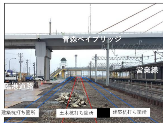
写真-1 青森駅構内
