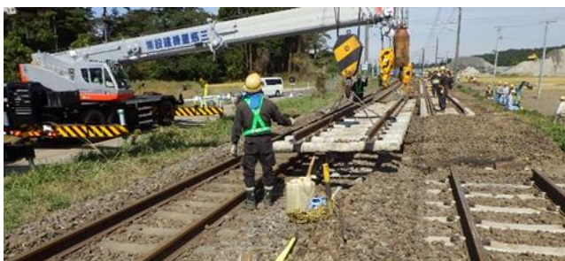
写真-2 ラフテレーンクレーンによる軌きょう撤去
