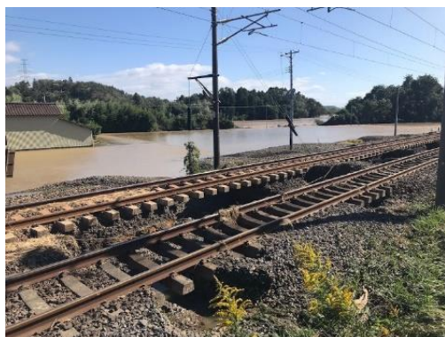
写真-1 施工現場状況(施工前)
