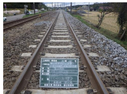
写真-2 復旧後の現場状況
