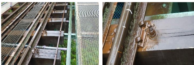
写真-1.2 橋マクラギ締結装置状態(施工前)
