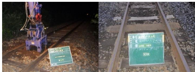
写真-6,7 事前継目マクラギ挿入
