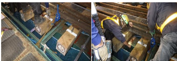
写真-4.5 ワイヤー荷締め機使用状況
