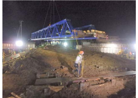
写真-4 工事桁架設状況
