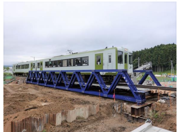
写真-5 工事桁架設後
