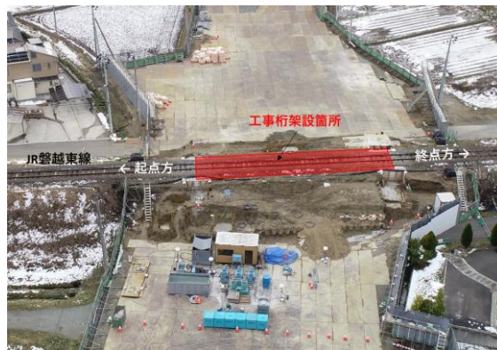
写真-1 工事桁架設前
