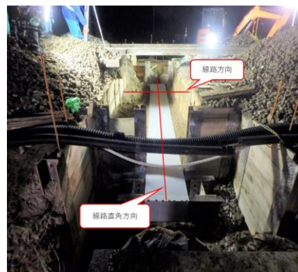
写真-3 転写フィルム使用状況
