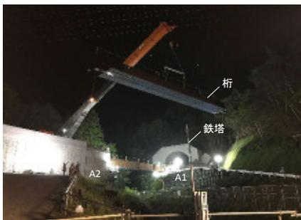
写真-1 桁旋回状況
