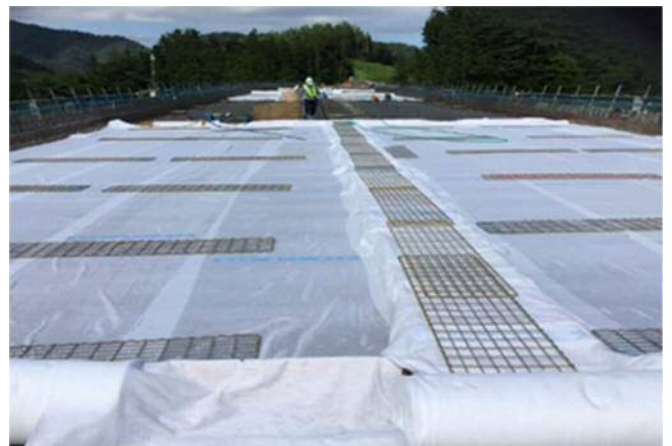
写真-3 養生状況写真
