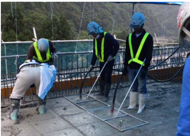
写真-2 締固め状況写真
