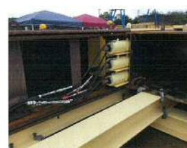
図-5 後行エレメントけん引ジャッキ 1)
