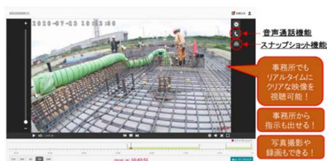
写真-3 現場巡視映像
