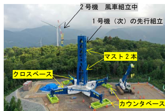
写真-4 タワークレーンの先行組立
