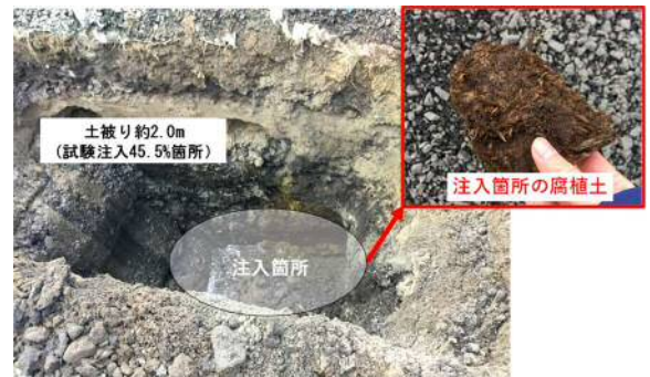
図-3 注入状況確認
