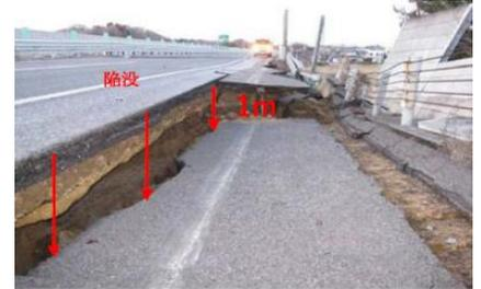
写真-1 道路盛土の被災状況<sup>1)</sup>
