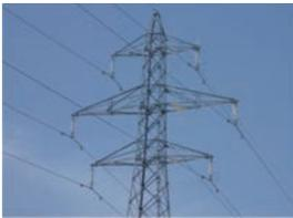
図-1 懸垂型送電鉄塔の例
